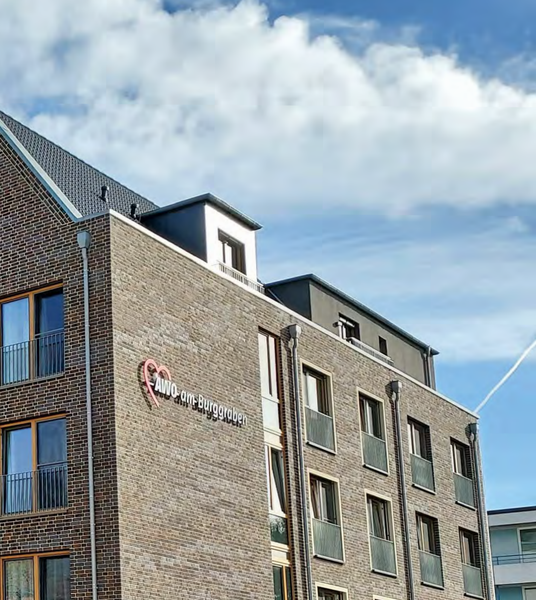
AWO am Burggraben. Der Neubau am Standort in Leer.
